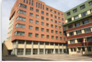
Pansiyon Dış Cephe 1
