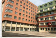
Pansiyon Dış Cephe 2
